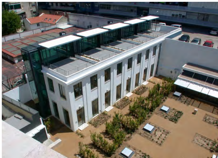
Vista de conjunto do logradouro—Edifício 2 e Anexo
