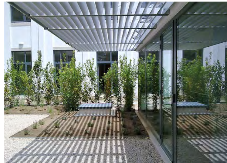
Pormenor do acesso ao Anexo
